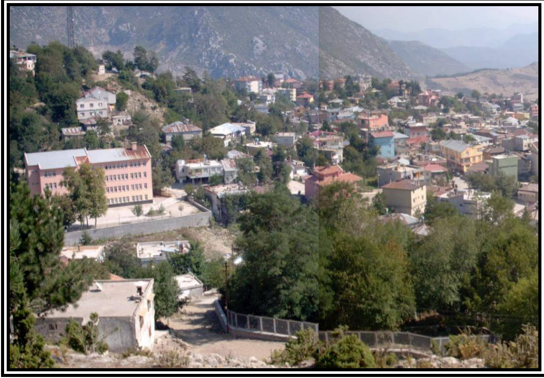
Foto 3.3. Genelde 2 ve 3 katlı binaların yaygın, 4 katlı binaların ise az bulunduğu Andırın'dan bir görünüm (2007).
