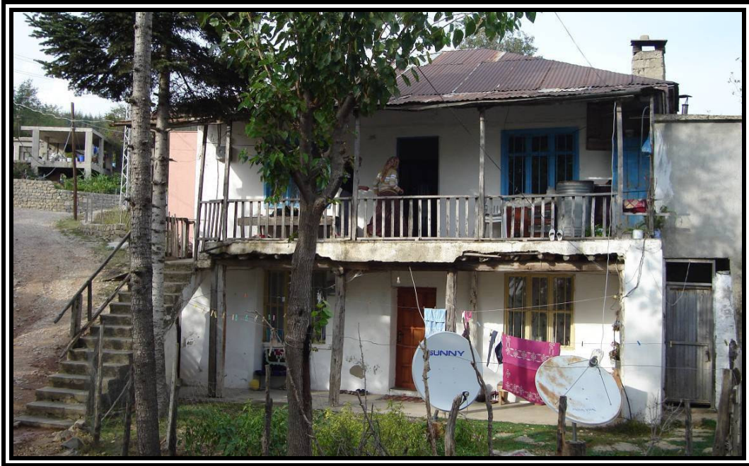
Foto 3.6. Ahşap malzeme ve çevreden temin edilen taşların yoğun olarak kullanılmasıyla yapılan ve iki kat şeklinde inşa edilen bu evlerin önceleri hayvan beslemek için kullanılan ilk katları daha sonraları hayvancılığın terk edilmesi ve yaz mevsiminde yaylacılığa bağlı artan kiralık ev taleplerine bağlı olarak bu evlerin ilk katları düzenlenerek yaylacılara kiraya verilen eski bir Andırın evinden bir görünüm (2007).
