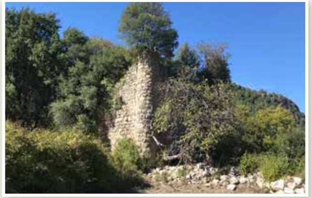
Yolumuz Burunönü kalesine uğruyor.
